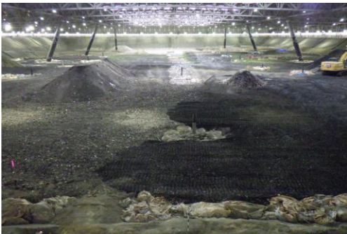
「エコアくまもと」 覆蓋施設埋立状況 (令和8年3月31日) ※埋立進捗率 53.9%
