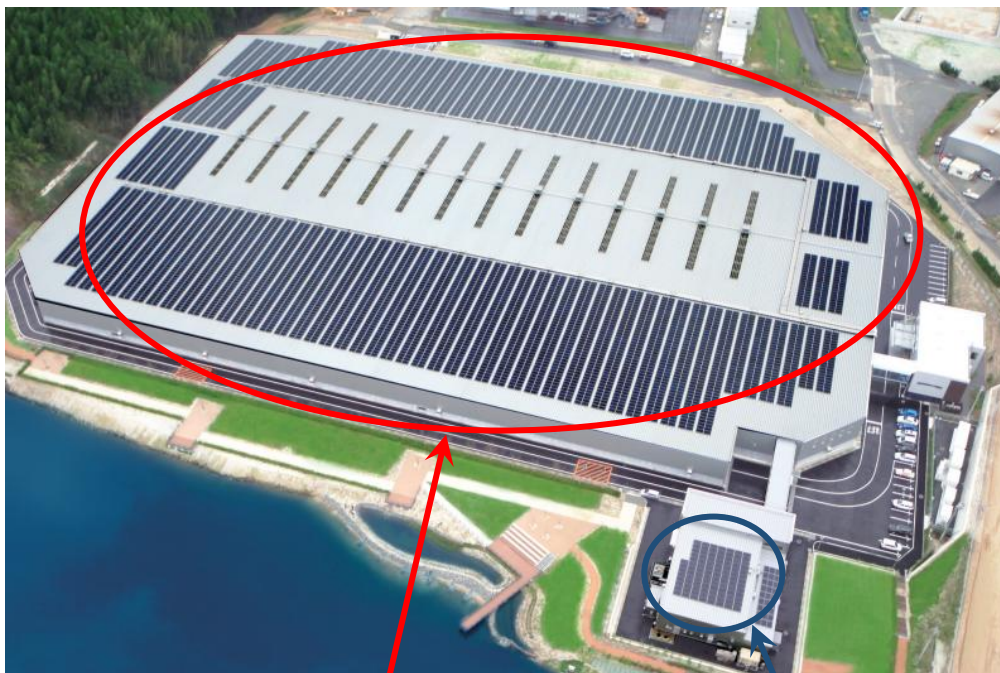
覆蓋施設 (埋立地)
