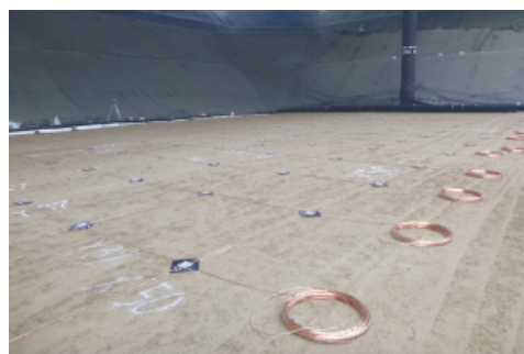
測定電極(中間保護土の上に設置)
